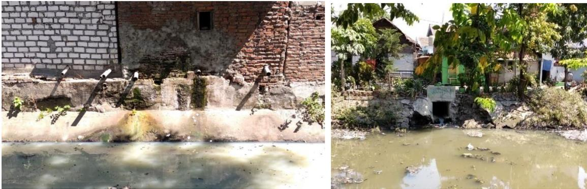
**Gambar 5. 1** Pipa Buangan dan Saluran yang menuju Sungai Kali Tebu
