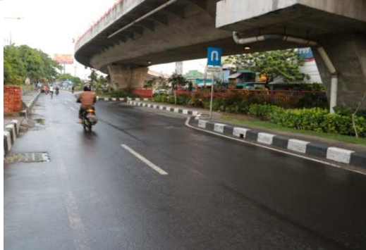
Bawah Jembatan Layang Wonokromo
