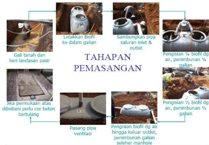
Gambar 4.13 Proses Dan Tahapan Pemasangan Biofilter
