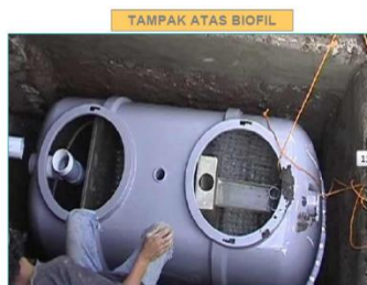
Gambar 4.11 Tampak Atas Biofilter
