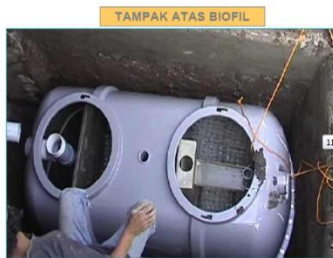
Gambar 4.11 Tampak Atas Biofilter
