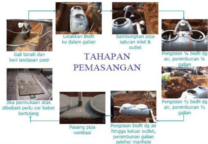
Gambar 4.13 Proses Dan Tahapan Pemasangan Biofilter
